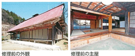
修理前の外観
