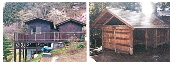
管理棟と展望デッキ
